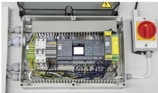
Speicherprogrammierbare Steuerung zur Ansteuerung des Biegewerkzeugs
