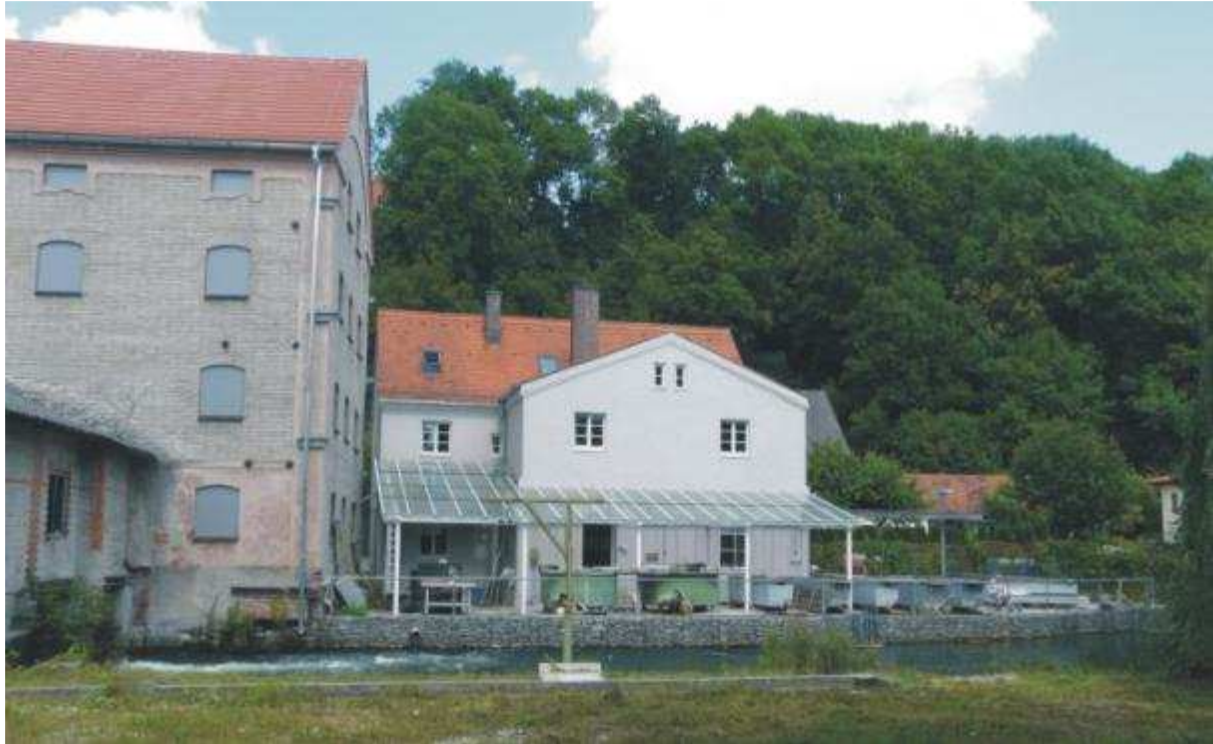
Abbildung 1 Lehrstuhl für Aquatische Systembiologie, Blick auf das Unterwasser der Moosach an der ehemaligen Mühle.
