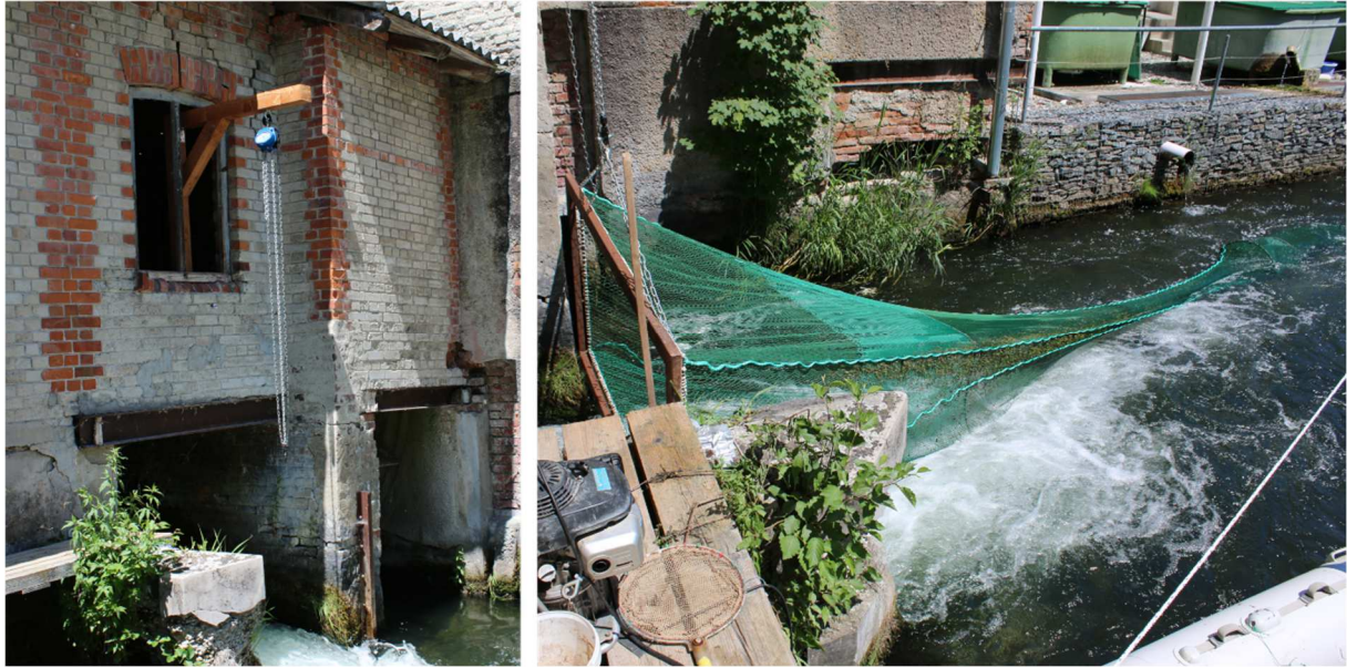
Abbildung 3 Links: Hebekonstruktion mit Flaschenzug für den Fanghamen, Rechts: Angehobener Hamen am Kettenzug.
