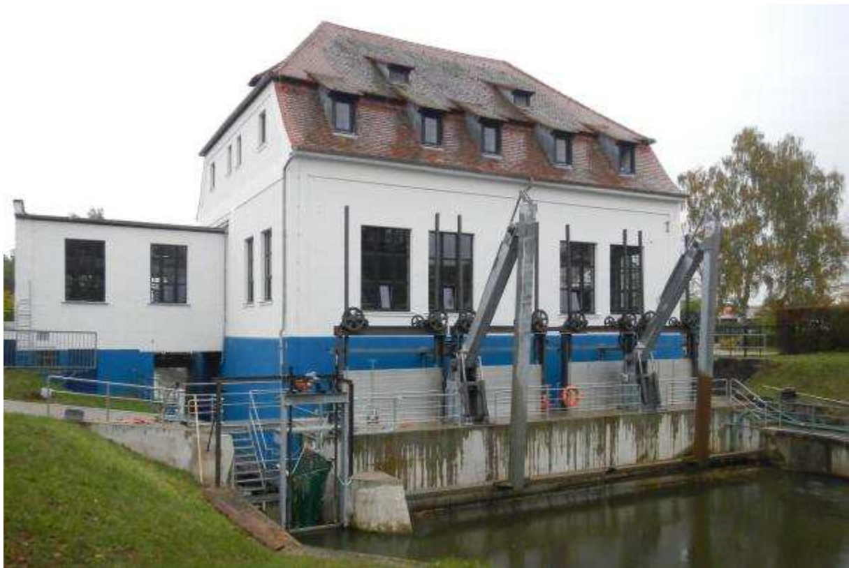
Abbildung 1 Wasserkraftanlage Baiersdorf-Wellerstadt an der Regnitz, Blick vom Oberwasser in Fließrichtung.
