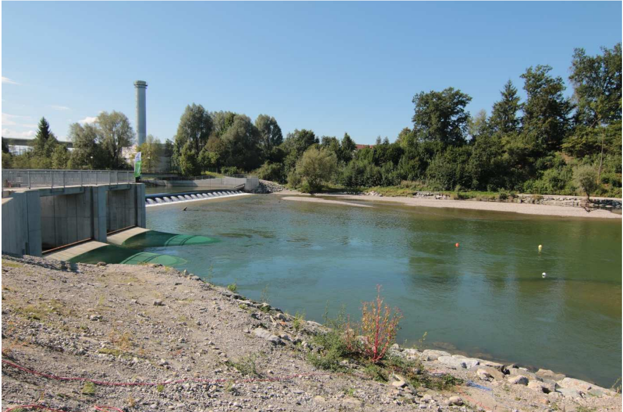
Abbildung 2 Kraftwerk Au/Illler nach der Fertigstellung, Blick vom Unterwasser auf die orografisch rechts gelegenen Turbinenausläufe. Orografisch links befindet sich das Schlauchwehr.
