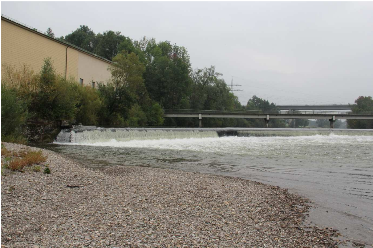
Abbildung 1 Wehranlage Au/Iller vor dem Bau des Kraftwerks, Blick vom Unterwasser auf die orografisch rechte Wehrseite.
