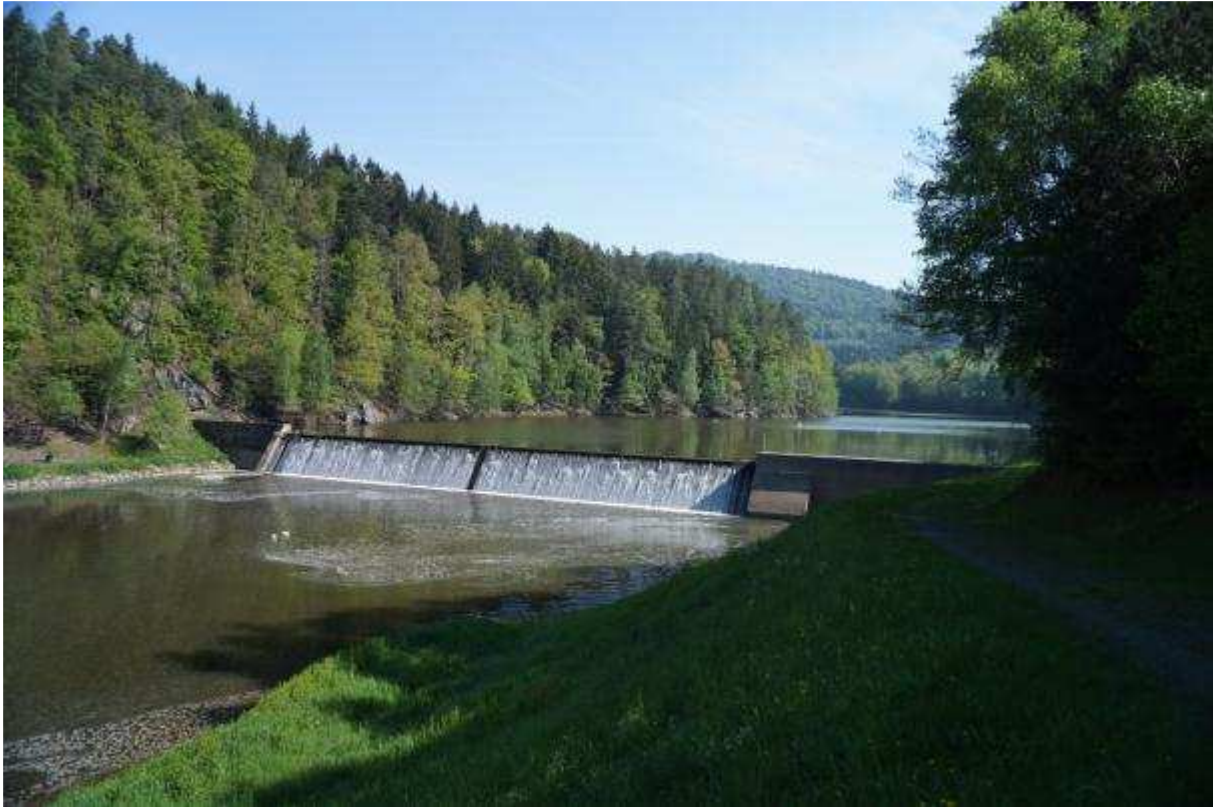
Abbildung 1 Speichersee Eixendorf vor dem Bau der Wasserkraftanlage, Blick auf das Stauwehr vom orografisch linken Ufer.
