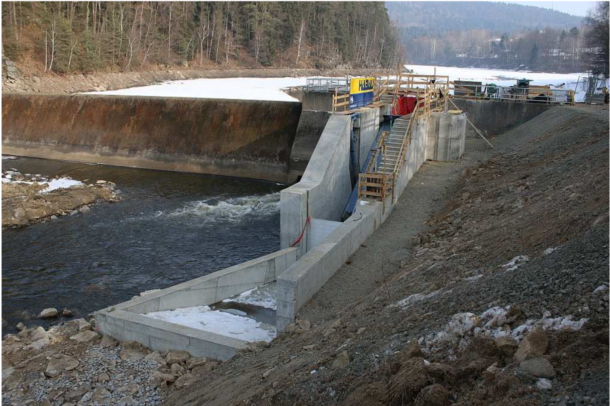
Abbildung 2 Speichersee Eixendorf nach dem Bau der Wasserkraftanlage, Blick auf das Stauwehr vom orografisch linken Ufer.
