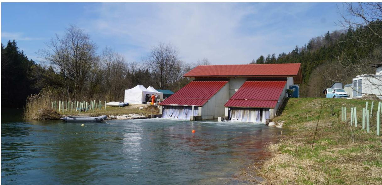
Abbildung 1 Turbinenauslässe der beiden Wasserkraftschnecken am Standort Hölthal/Alz.
