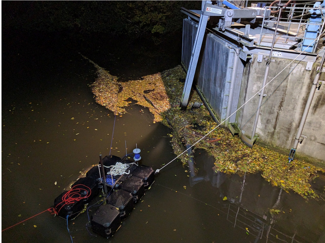
Abbildung 40 Mobiles Modul II vor der Wasserkraftanlage Lindesmühle/Fränkische Saale in Bad Kissingen.
