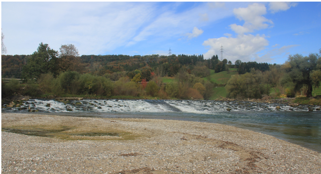
Abbildung 2 Blick vom Unterwasser auf die raue Rampe am Standort Großweil vor dem Bau des Kraftwerks.
