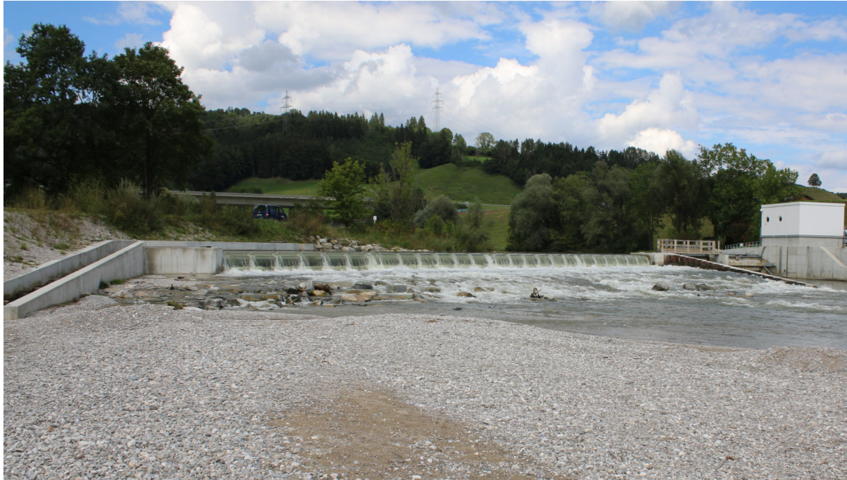
Abbildung 3 Blick vom Unterwasser auf die orografisch rechte Fischaufstiegsanlage, das Klappenwehr und das Kraftwerksgebäude am Standort Großweil.
