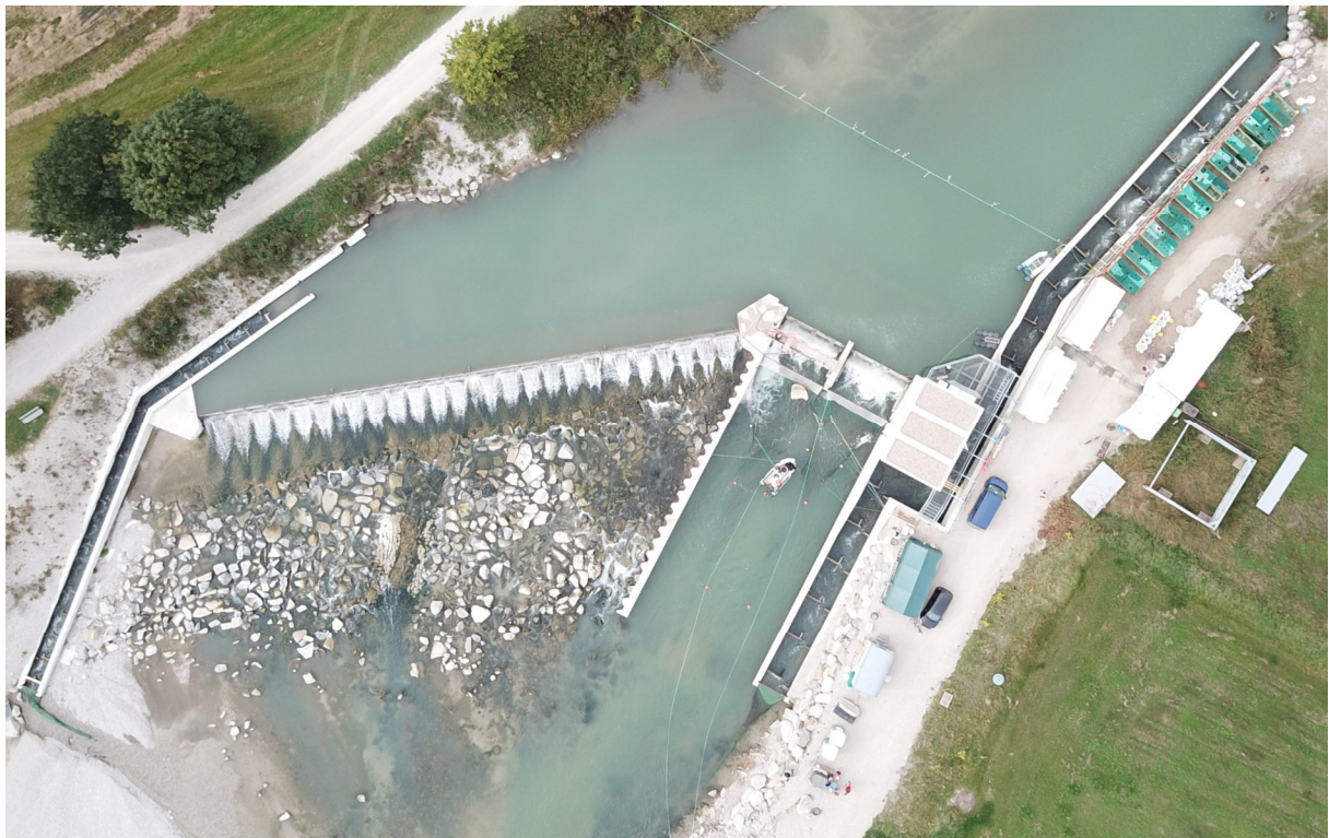
Abbildung 1 Drohnenaufnahme der Kraftwerksanlage am Standort Großweil.
