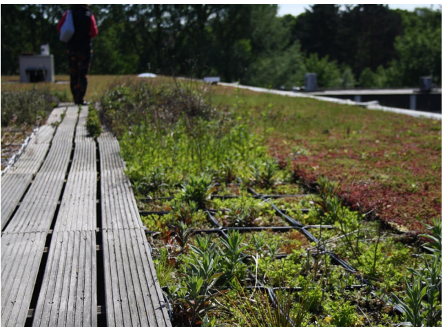
Abbildung 16: Extensive Dachbegrünung (Foto: ZSK TP1)
