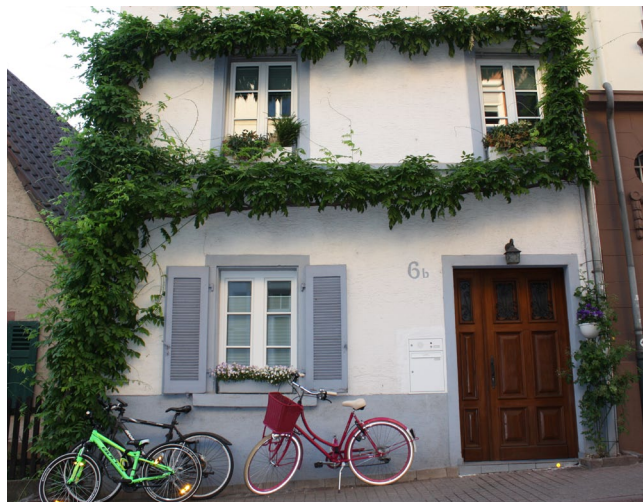
Abbildung 100: Fassadenbegrünung am Wohngebäude (Foto: ZSK TP1)
